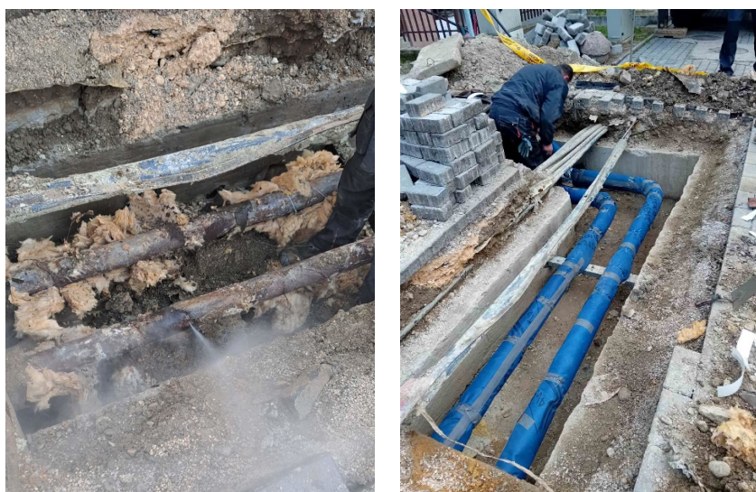
Слика 2 Санација на дефект на ул.Донбас бр.1
